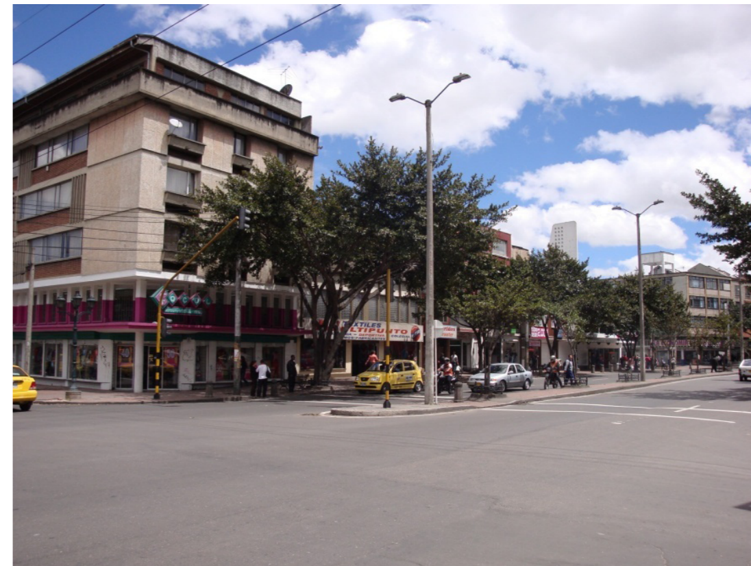
Fuente: Archivo Fotográfico. Hospital Chapinero. 2009.
