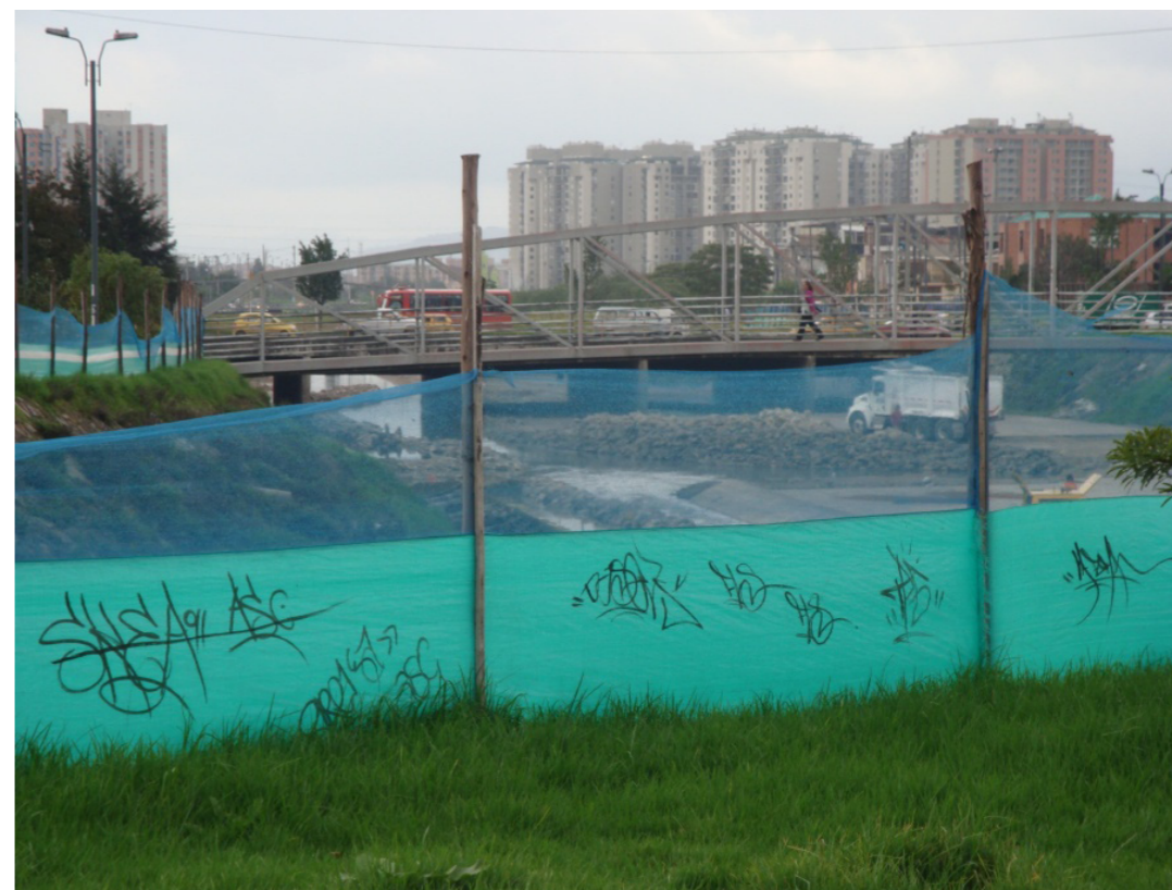
Foto 10: Punto Crítico de Estancamiento de Aguas. Entrerrios-Cafam La Floresta.
