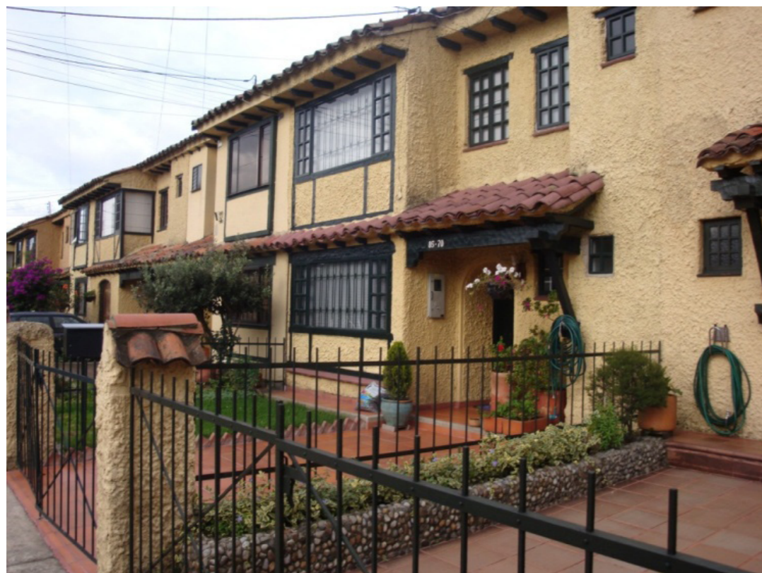
Fuente: Archivo Fotográfico. Hospital Chapinero. 2010.
